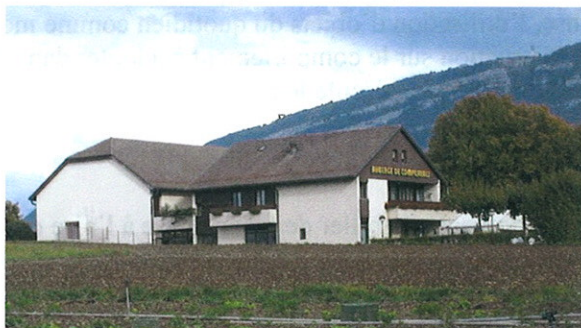
Salle communale de Compesières
